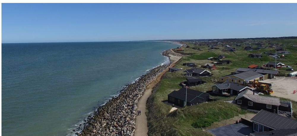
Figur 5.8 Passiv skråningsbeskyttelse bevirker, at stranden forsvinder, Harrerenden Nordjylland.
