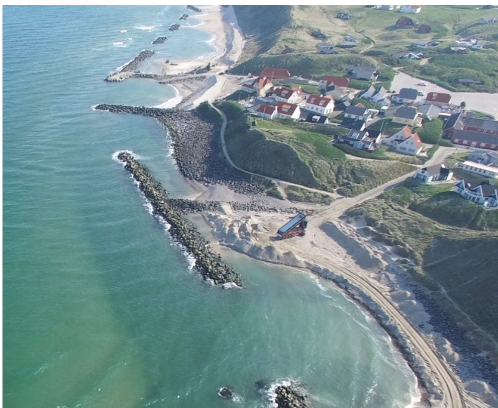
Figur 5.4 Bølgebryder hvor erosionen forøges, fordi kystens orientering ændres. Der kompenseres for erosionen med sandfodring som det ses midt i billedet.
