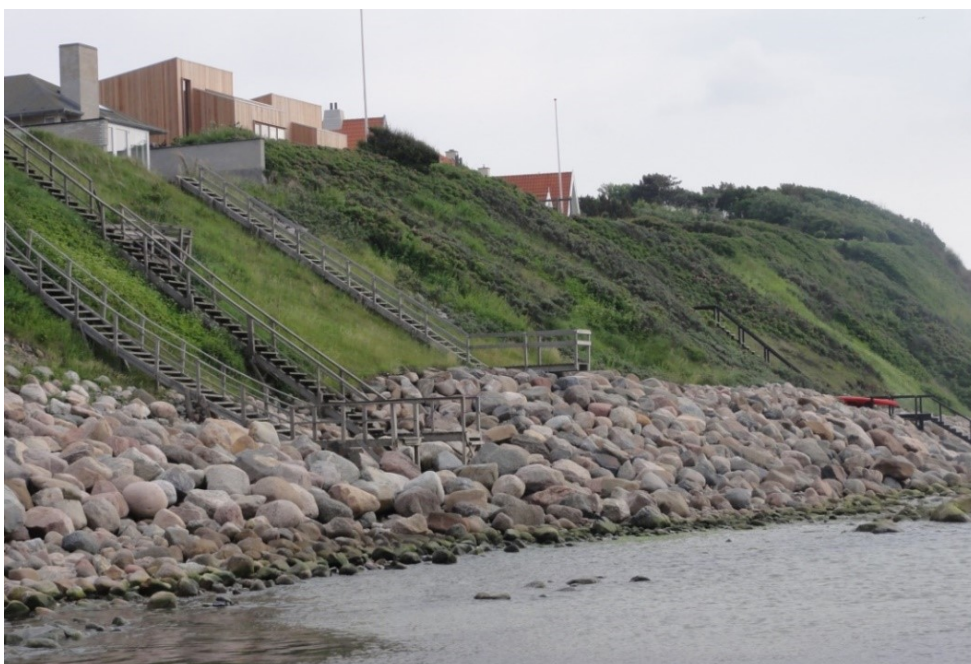
Figur 4.20 Eksempel på virkning af hård skråningsbeskyttelse. Stranden er forsvundet. Liseleje før det ”nye” bølgebryderprojekt.
