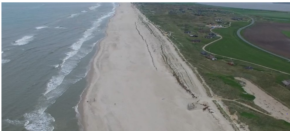
Figur 5.1 Dige/klit med sandfodring foran for at kompensere for erosionen og bryde bølgerne. Fyrretoppe og hjelme er nedsat foran klitten for at mindske vindtransporten af sand hen over klitten.
