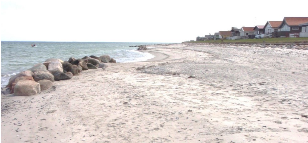
Figur 5.2 Dige med sandfodring for at kompensere for erosionen og bølgebrydere for at reducere bølgepåvirkningen på diget
