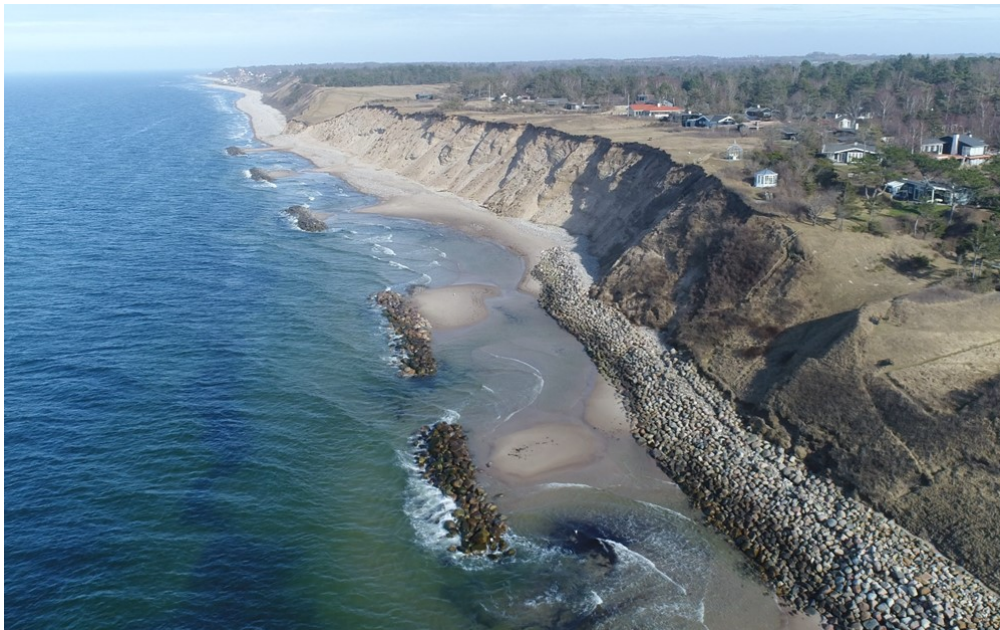
Figur 5.5 Bølgebrydere med kompenserende sandfodring
