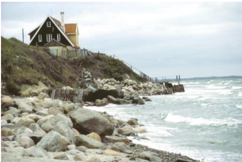
Figur 4.20 Eksempel på virkning af hård skråningsbeskyttelse. Stranden er forsvundet. Liseleje før det ”nye” bølgebryderprojekt.
