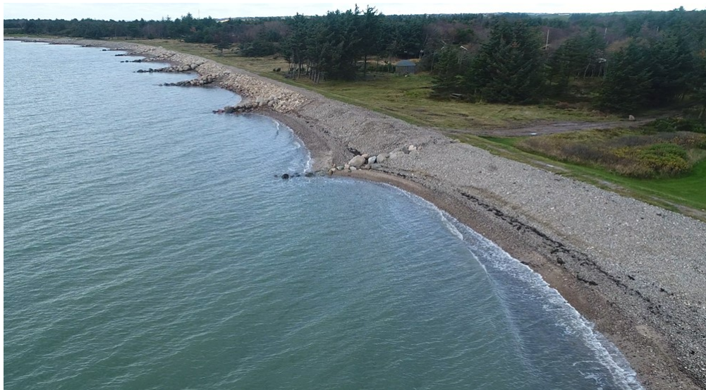
Figur 5.9 Dige beliggende på forstrand udsat for erosion
