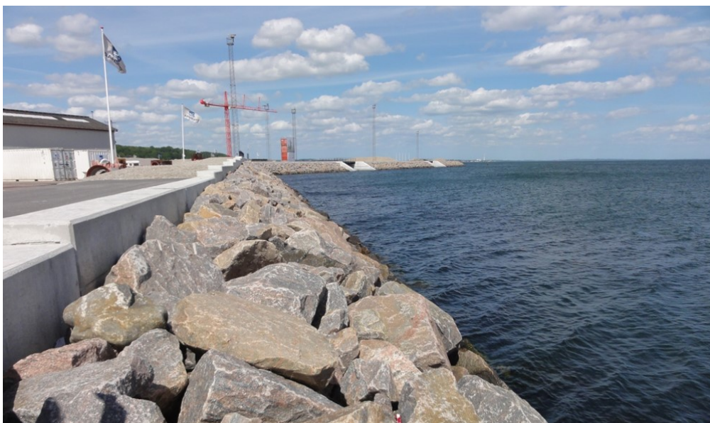
Figur 5.3 Bølgebrydende skråningsbeskyttelse med undersøisk banket
