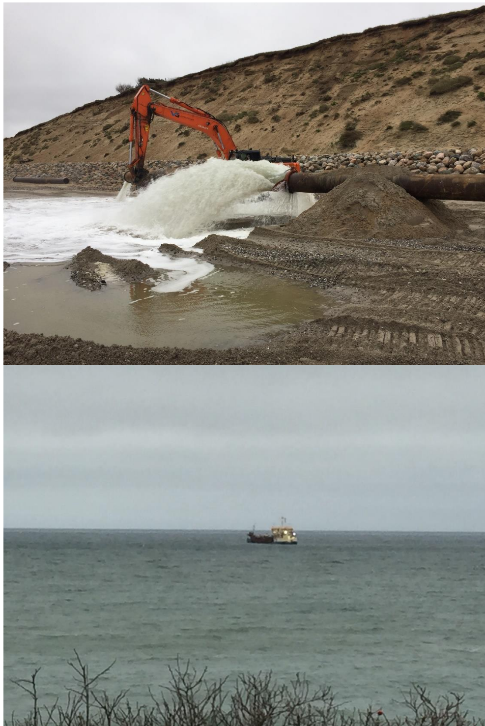
Figur 3-5 Eksempel på sandfodring ved Vincenstien/Heather Hiil på nordkysten af Sjælland. Øverste billede viser sandfodringen på stranden hvor rørledningen placeres langs stranden til udpumpning af sand (blandet med vand.). På det nederste billede vises en sandsuger-fartøj udfor kysten. (fotos OJJ, COWI)
